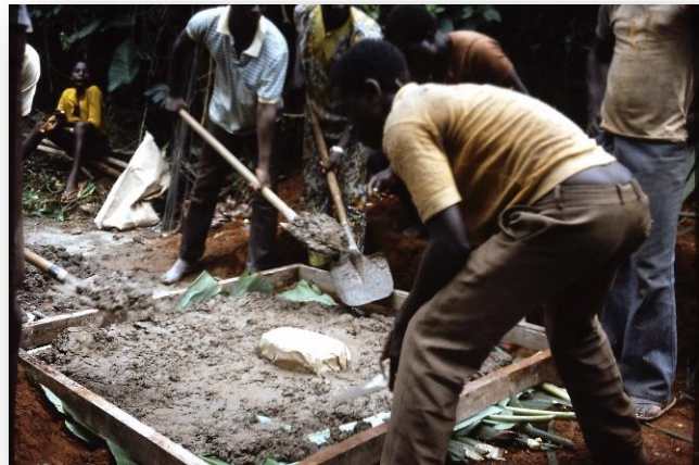
... waarop de cementen vloer wordt gestort.
