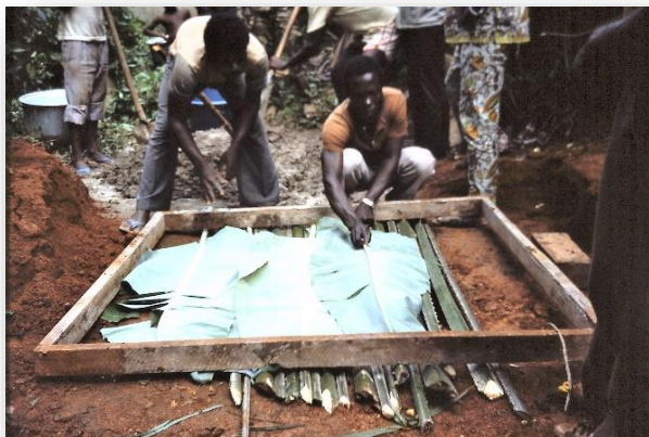
De latrineput wordt eerst afgedekt met lokaal materiaal...
