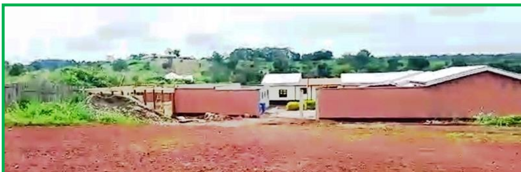
Het scholencomplex, toen nog in aanbouw
