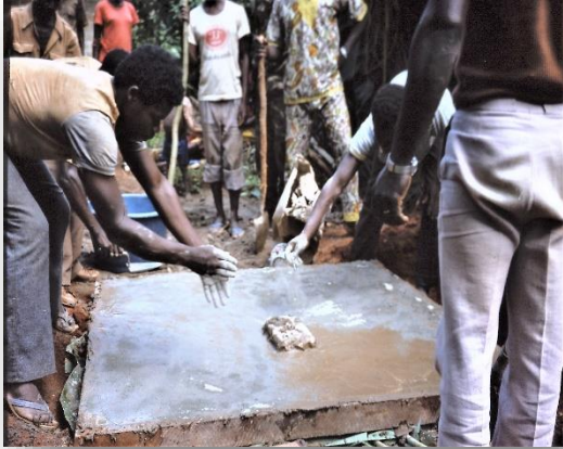
...en als afwerking een laagje puur cement, ter egalisatie
