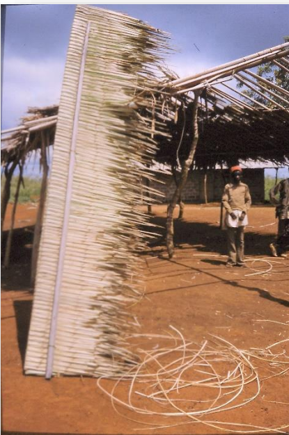
Traditioneel huis in aanbouw, met gevlochten palmladeren voor het dak.
